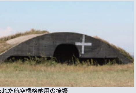
戦時中に造られた航空機格納用の掩壕
