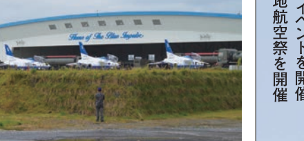
ブルーインパルスの格納庫もかさ上げされた
