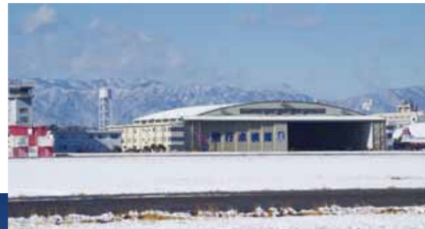
飛行点検隊本部庁舎及び格納庫全景
