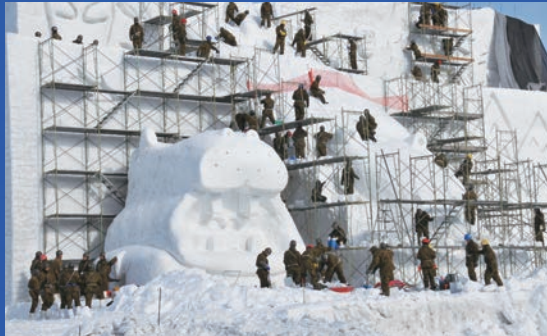
大雪像の上の部分に雪ブロックを積み上げる
