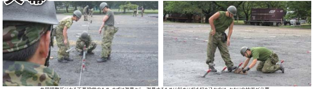
共同調整所になる天幕設置のため、まずは測量から。測量するために斜めに杭を打ち込むのは、かなりの技術が必要
