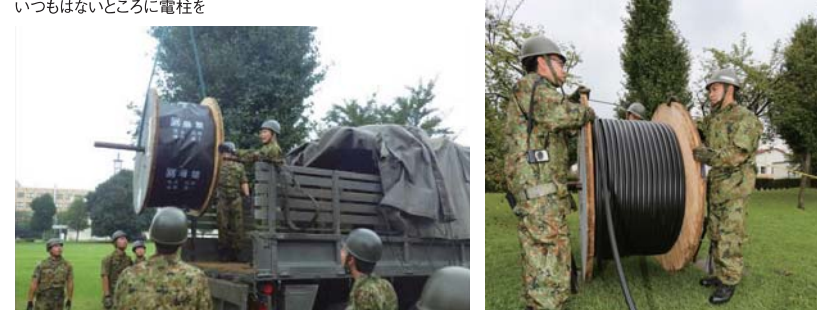
ケーブルはクレーンで搬送
