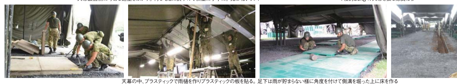
天幕の中、プラスチックで雨樋を作りプラスチックの板を貼る。足下は雨が貯まらないように角度を付けて側溝を掘った上に床を作る
