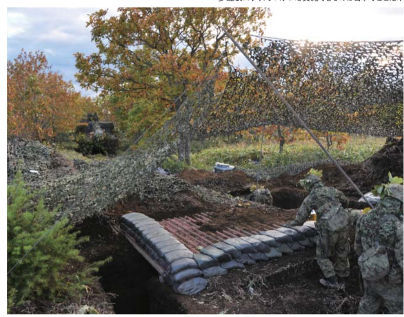
第2特科連隊 火砲陣地構築
