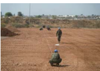
仮宿営地設営のための計測
