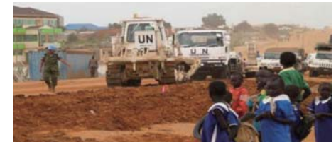
首都ジュバ周辺の道路修復作業
