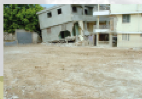
瓦礫除去終了後
