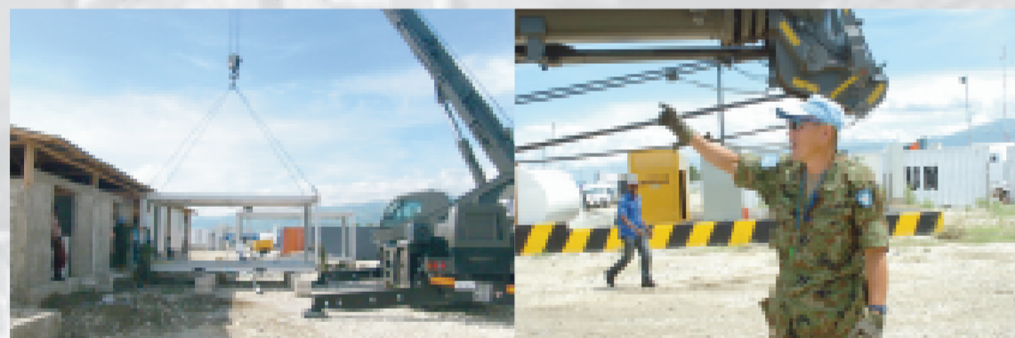
日韓共同の「倒壊した学校」の解体及び瓦礫除去
